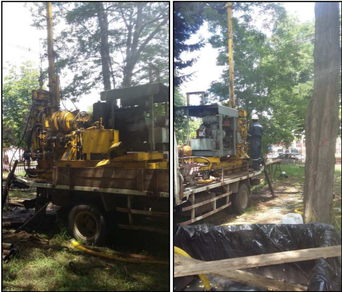
Instalación Máquina Sondaje
